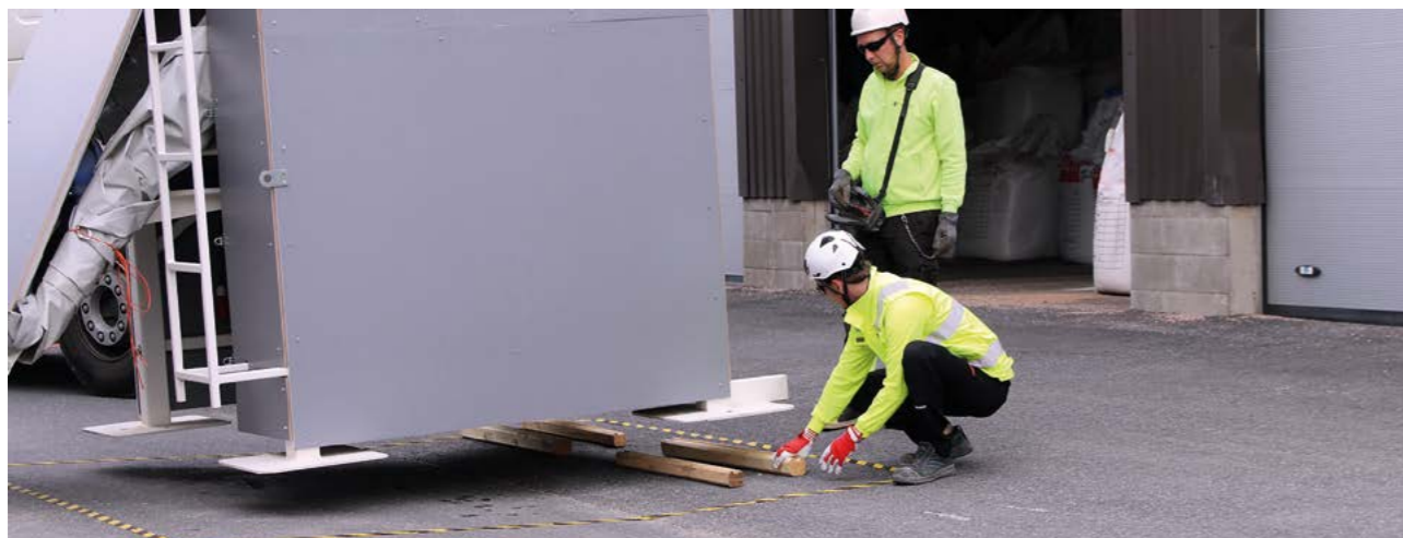
Työmaasiilo asennetaan kahden asteen kulmaan putkisekoittajan suuntaisesti.
