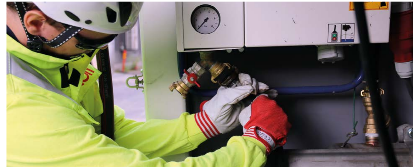
Kiinnitä toimituksen mukana tuleva vesiletku ohjauksyksikön vesiliittymän ja automaattisekoittajan väliin.
